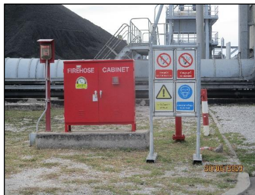
รูปที่ 2-12 ตู้เก็บสายดับเพลิง ( Fire Hose Cabinet) บริเวณลานกองถ่านหิน
