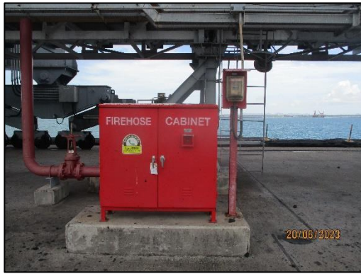
รูปที่ 2-18 ตู้เก็บสายดับเพลิง ( Fire Hose Cabinet) และถังดับเพลิงแบบพกพา (Fire Extinguisher) บริเวณท่าเรือของโครงการ ฯ
