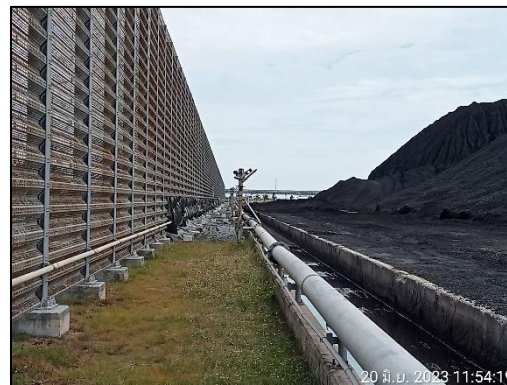
รูปที่ 2-2 การติดตั้งระบบสเปรย์น้ำโดยรอบลานกองถ่านหิน
