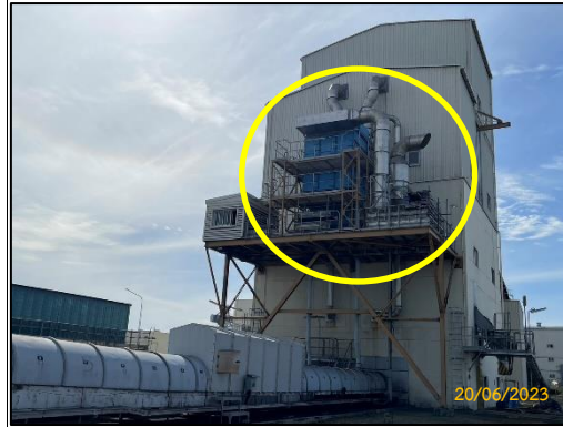
รูปที่ 2-10 ระบบ Dust Prevention Hood ที่ติดตั้งที่อาคาร Transfer Tower
