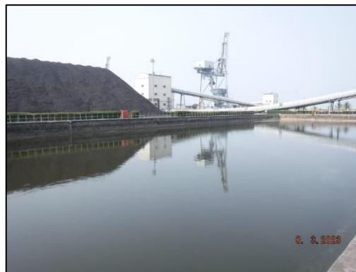
รูปที่ 2-15 บ่อดักตะกอนบริเวณลานกองถ่านหินของโครงการฯ
